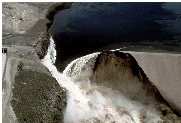
Figura 3.- Falla de la presa Teton, en el río Teton, al este de Idaho, el 5 de junio de 1976. Posiblemente se trate de un caso raro de una onda cinemático-dinámica mixta.
